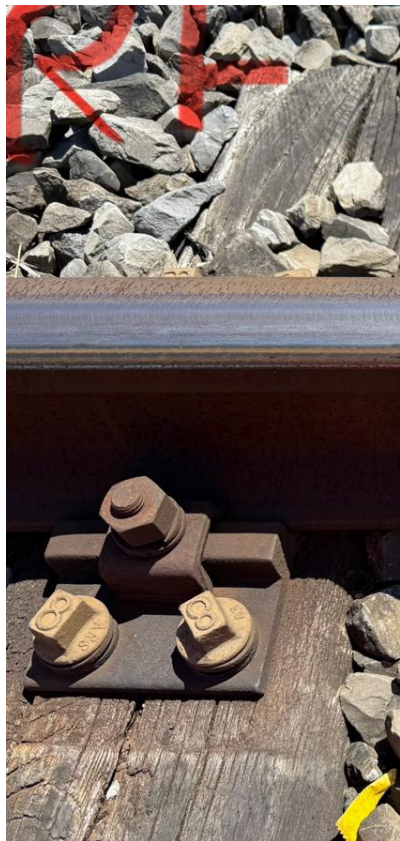
Abbildung 25: EN 54E2 Schiene Gleis 75 mit normalem Fahrspiegel
