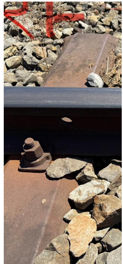
Abbildung 27: EN 46E1 Schiene Gleis F7 mit breitem Fahrspiegel
