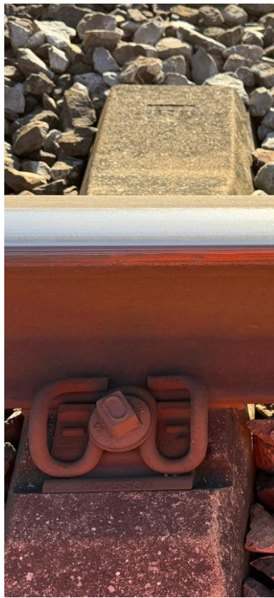
Abbildung 26: EN 60E2 Schiene Gleis 74 mit normalem Fahrspiegel
